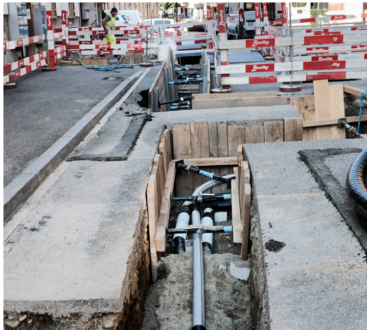
Wenn Gemeinden Abwasserrohre sanieren, können sie gleichzeitig Leerrohre für Glasfaserkabel unter der Strasse verlegen. Foto: F. Wyss, EspaceSuisse
